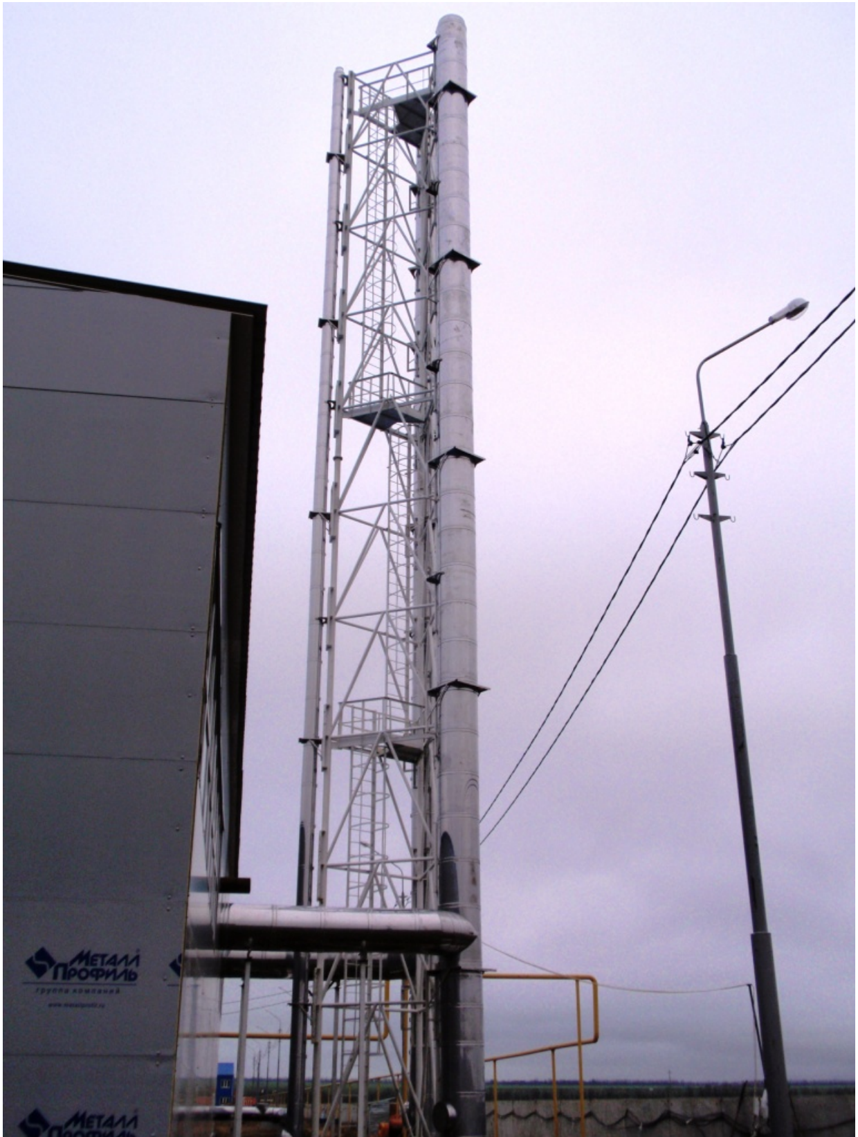
г.Светлоград, Ставропольский край Дымоходы ф800х900мм, 2шт, Н=32м
