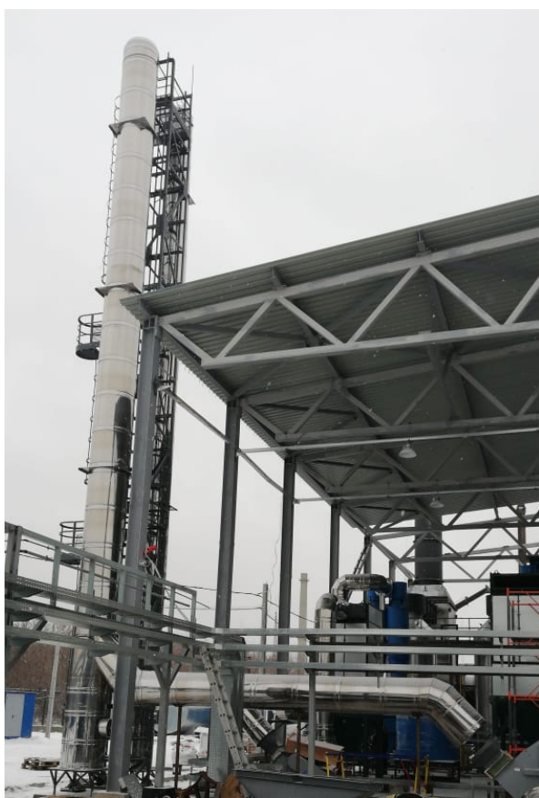
г.Дзержинск, завод по утилизации промышленных отходов дымоходы ф600х700мм, ф900х1000мм, Н=25м
