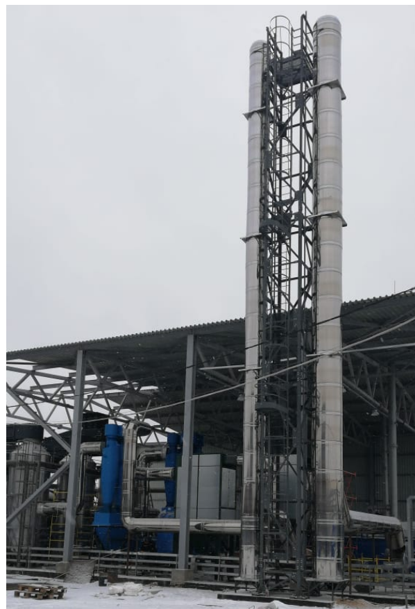
г.Дзержинск, завод по утилизации промышленных отходов дымоходы ф600х700мм, ф900х1000мм, Н=25м
