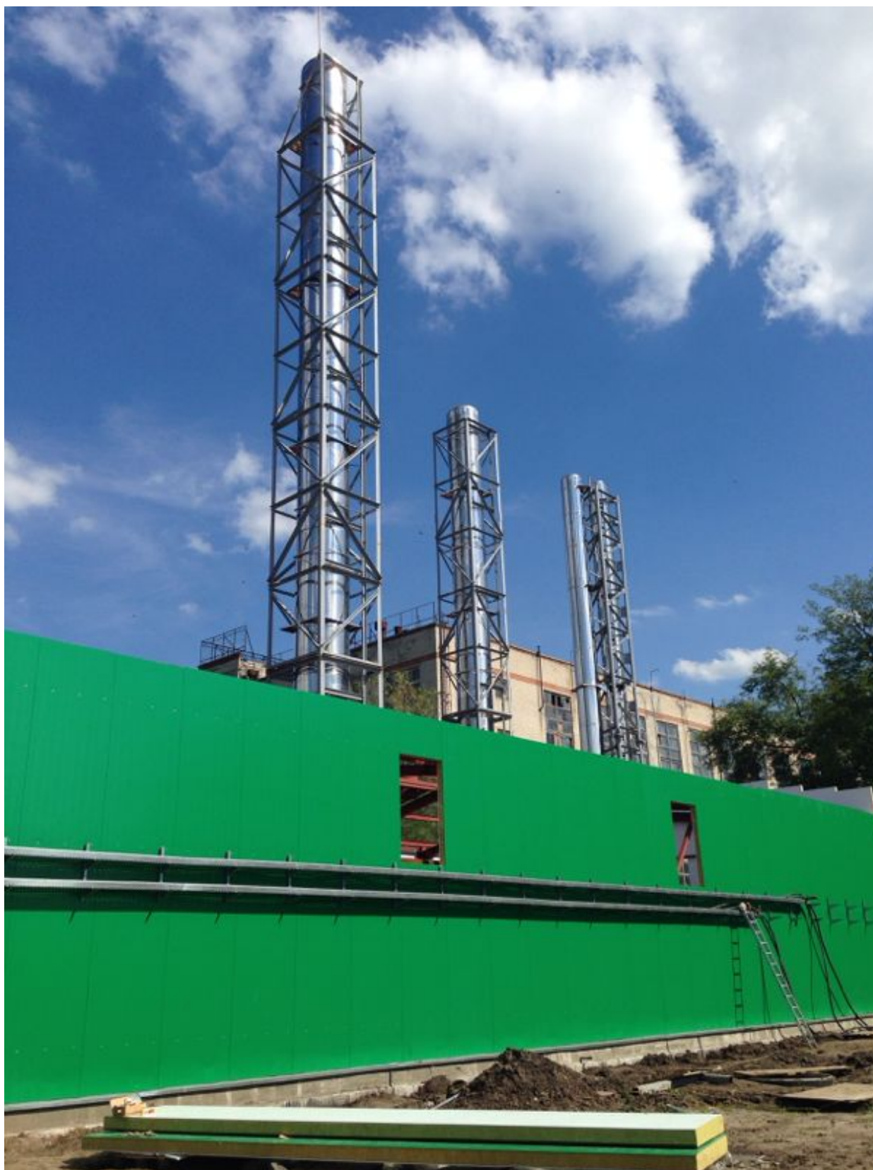
г.Курск, ООО «Курскхимволокно» ф1000х1100мм Н=20м, Ф700х800мм Н=14м, ф350х450мм Н=14м.
