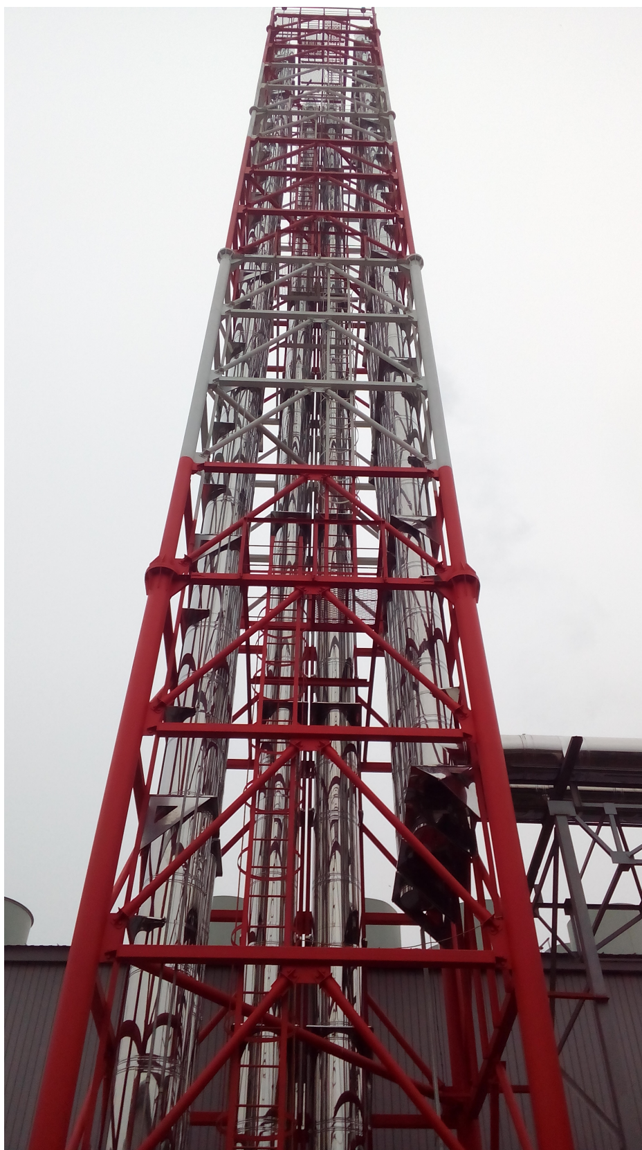
г.Ростов-на-Дону, «Донской табак» дымоходы \phi 350 \times 550 мм 4 шт., \phi 500 \times 600 мм 3 шт. H=45 м
