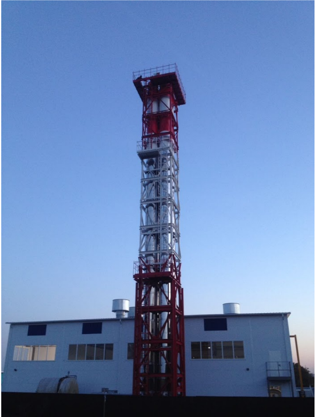
г.Краснодар, котельная по ул.Россинского, дымоходы \phi 1000 \times 1100 мм, Н=30м
